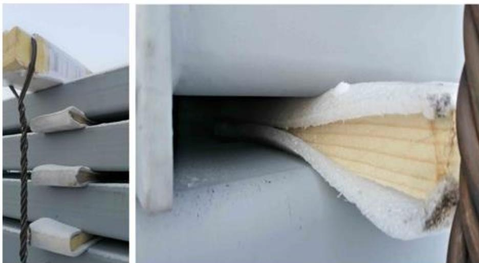
Рисунок 9. Пример использования подкладочного материала
