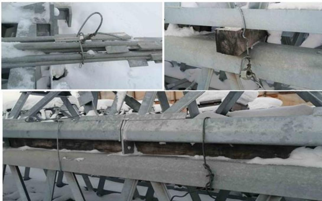
Рисунок 11. Пример неправильной обвязки проволокой металлоконструкций с нанесенным защитным покрытием
