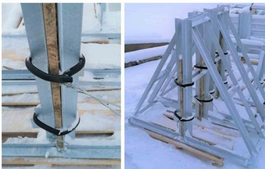
Рисунок 10. Пример правильной обвязки металлоконструкций с нанесенным защитным покрытием
